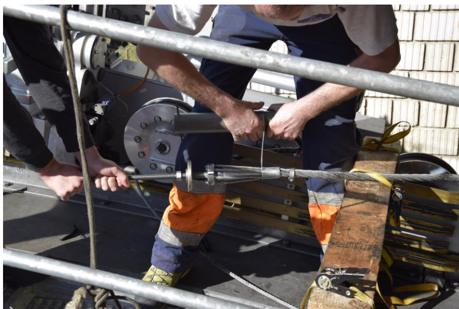
Der Klemmkopf, der das Zugseil mit der Kabine verbindet, wird neu erstellt.
