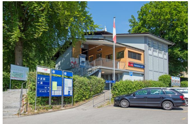
Nach der Sanierung wirkt die Talstation frisch und einladend.
